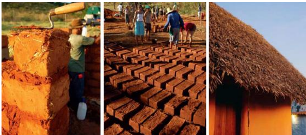
11- Participação ativa da população na autoconstrução através de blocos de adobe.
