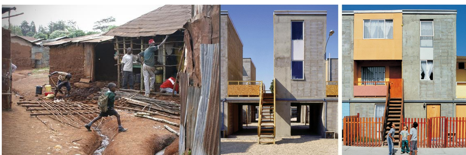
13- à esq. autoconstrução com estrutura de pau e pique à vista. À dir. Projecto de arquitectura evolutiva da Elemental (Alejandro Aravena)
